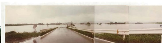
0k800付近右岸の境内浸水状況(新地地区:24日10時頃)
