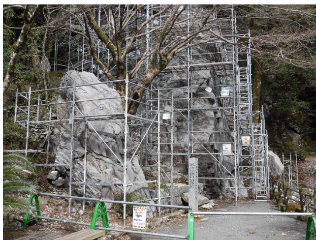
▲改修工事の状況
