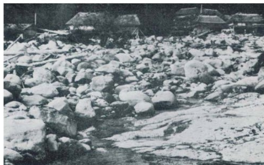
▲湯野尾町中島付近の流失した水田
