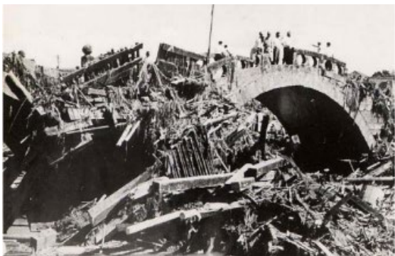
▲流木が堆積した眼鏡橋
