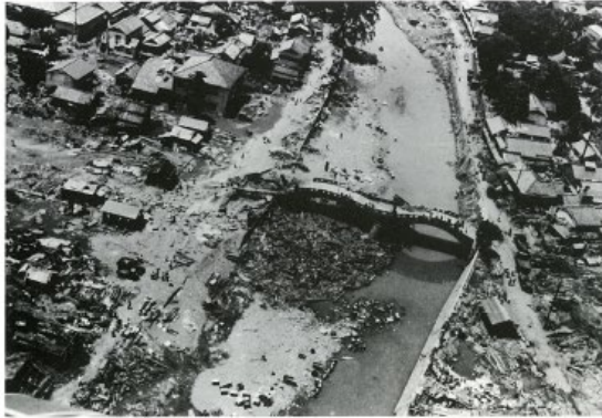
▲眼鏡橋両岸の流失状況
