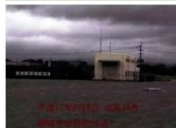
⑦都城市 高木原揚水機場 大淀川右岸 70k900
