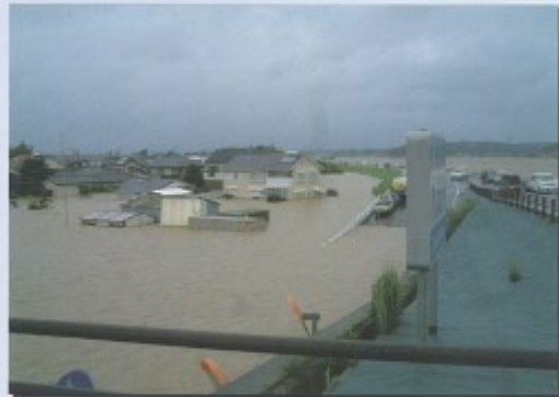
宮崎市下小松 平和台大橋上流 大淀川右岸(8k700)
