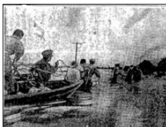
▲嘉瀬村の被災状況
