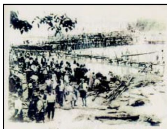
▲橋梁の復旧工事
