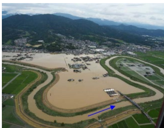
▲大町町付近の浸水状況
