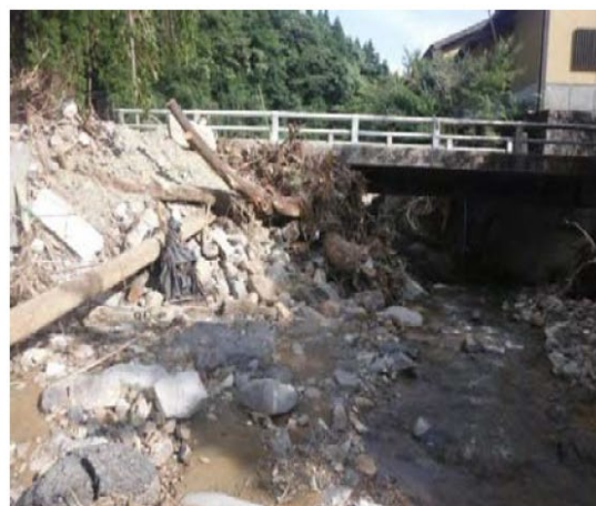
▲大肥川被災状況
