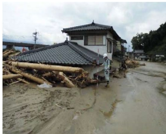
▲北川被災状況
