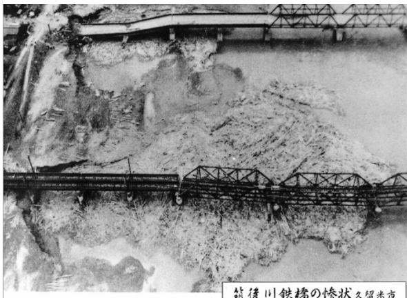
▲久留米市宮の陣橋と陣鉄橋
