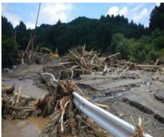
▲赤谷川被災状況
