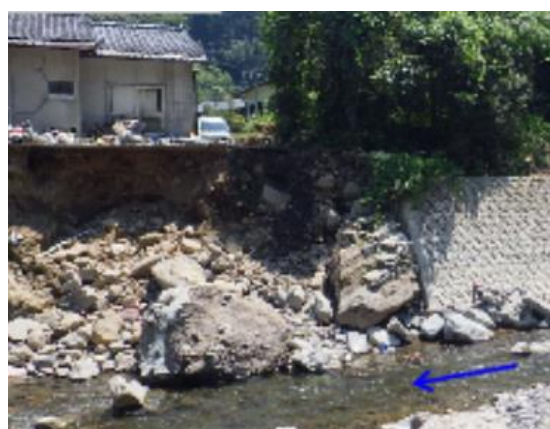
▲護岸が崩落した球磨川水系芋川
