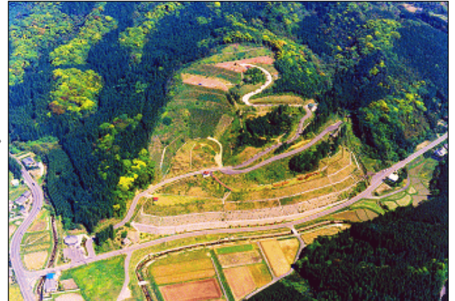
▲地すべり対策工完成時（平成 12 年 3 月）
