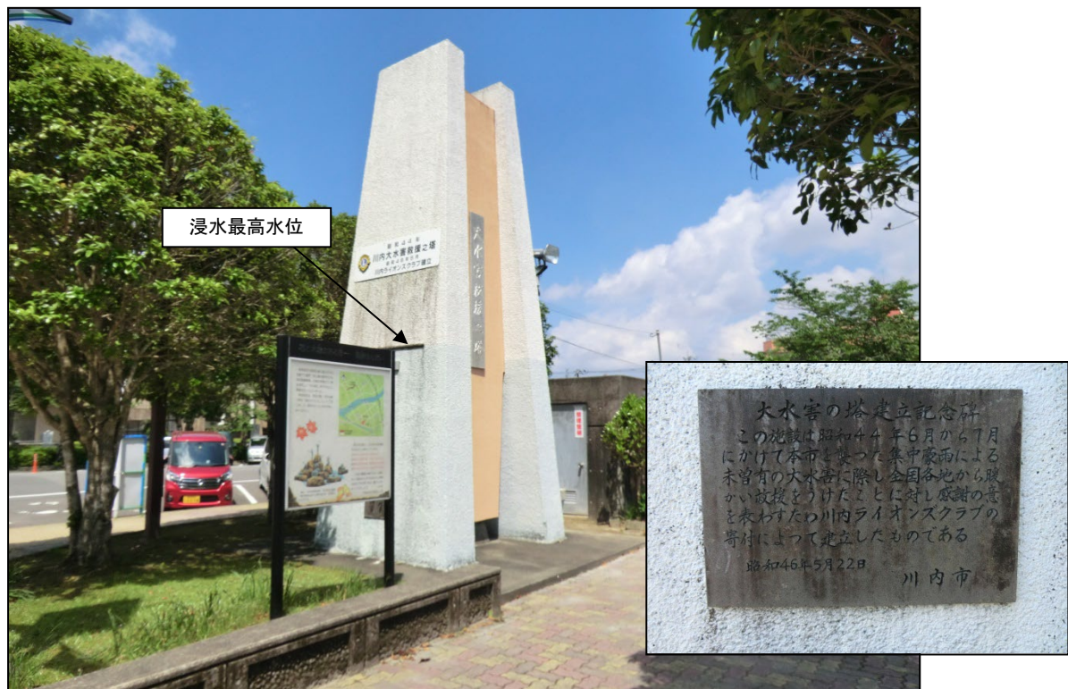
▲薩摩川内市役所前の向田公園内にある「大水害救援之塔」
