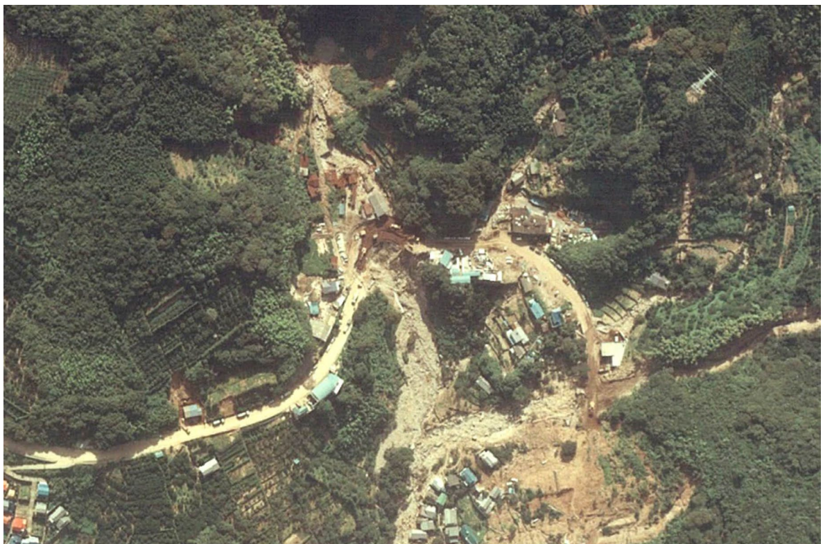
▲国道 34 号(芒塚付近)の大規模崩落の状況
