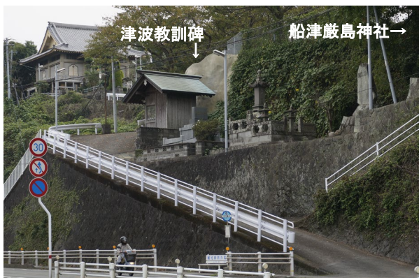
▲前面道路から見た位置 （神社東参道入口にあったが道路改良で現在地に移設）
