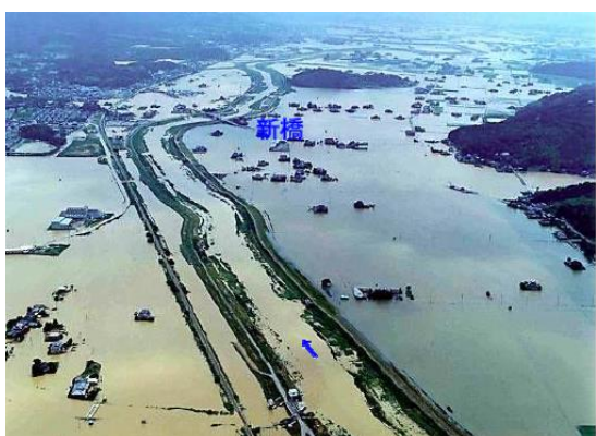
▲武雄市北方町での浸水状況
