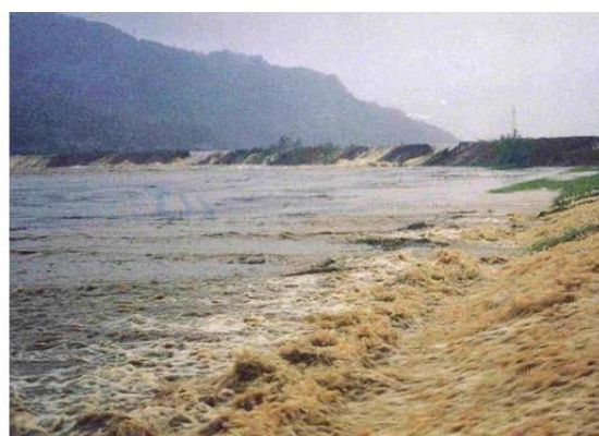
▲東多久町での堤防の越水状況
