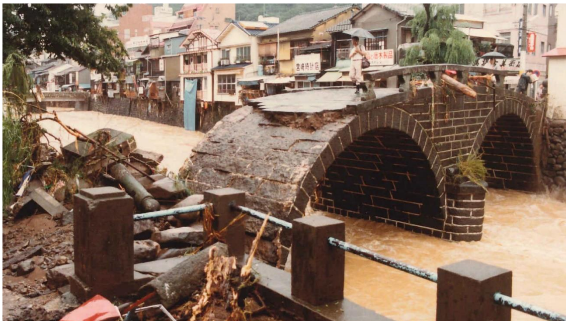
▲ 中島川の氾濫により一部流出した国指定重要文化財の眼鏡橋 出典：長崎県 HP
