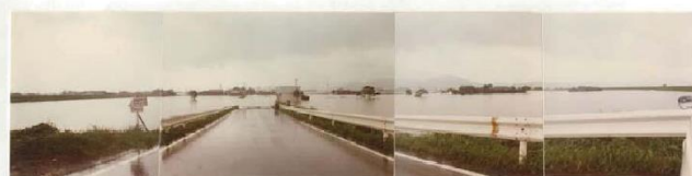
Ok800付近右岸の境内浸水状況(新地地区:24日10時頃)
