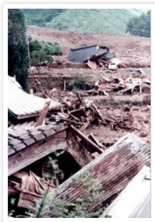
▲倒壊・流失した家屋の状況
