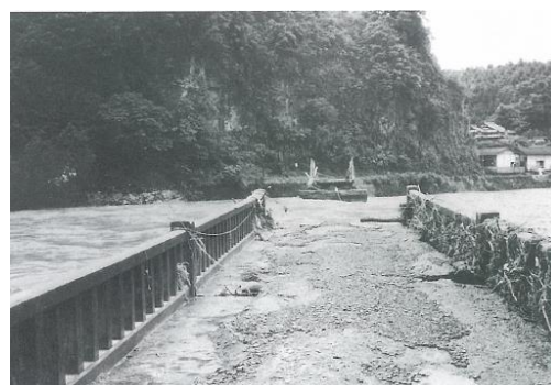
▲西瀬橋（人吉市）
