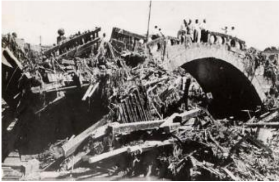
▲流木が堆積した眼鏡橋
