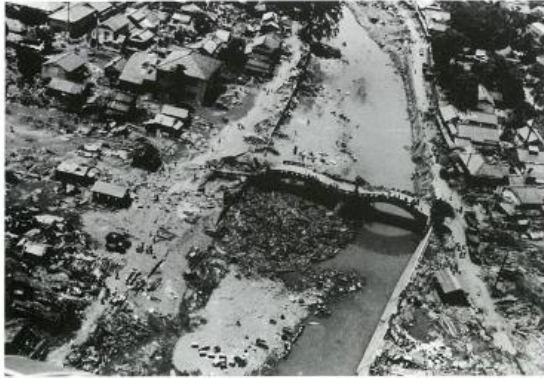
▲眼鏡橋両岸の流失状況
