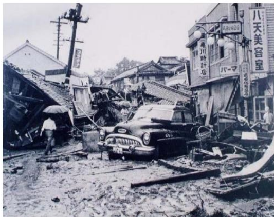
▲八天町の倒壊した家屋群
