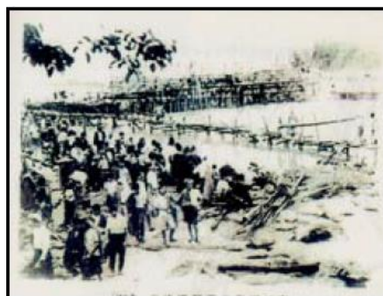
▲橋梁の復旧工事
