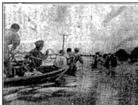
▲嘉瀬村の被災状況
