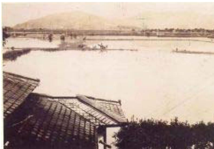
▲小城市芦刈町での浸水状況
