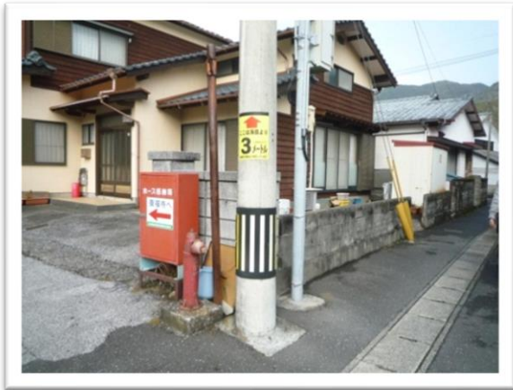
▲津波高さの標識整備状況①
