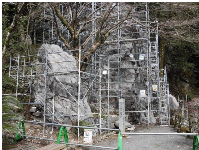
▲改修工事の状況
