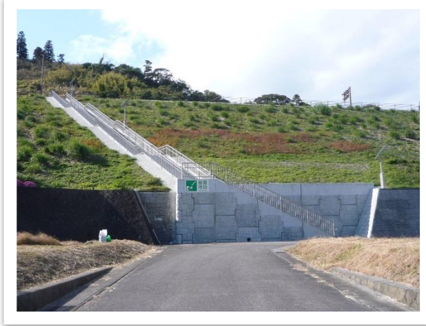
▲直轄国道 220 号（青島地区）の避難階段②
