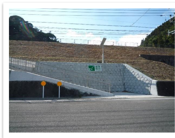
▲直轄国道 220 号（青島地区）の避難階段①
