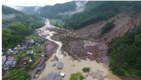
▲小野地区の土砂災害 (大分県日田市)
