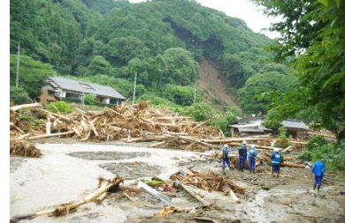
▲奈良ヶ谷川の流木被害 (福岡県朝倉市)
