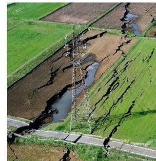
▲地盤の亀裂、地滑りによる支持物の傾斜
