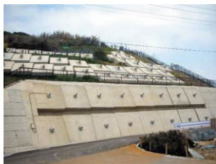
▲アンカー工事 (玄界島)
