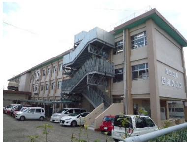
▲宮崎市立赤江小学校の非常階段（宮崎市）
