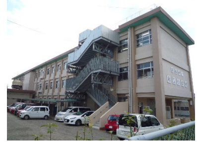
▲ 宮崎市立赤江小学校の非常階段 (宮崎市)
