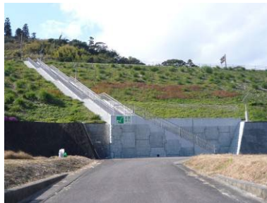
▲ 国道220号の避難階段 (宮崎市青島)
