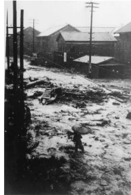
▲泥で埋まった国道 (門司区清滝付近) 画像出典:「あの日から50年」 (福岡県土木部砂防課)
