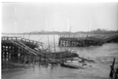
▲大分川 流出した舞鶴橋 (大分県大分市)
