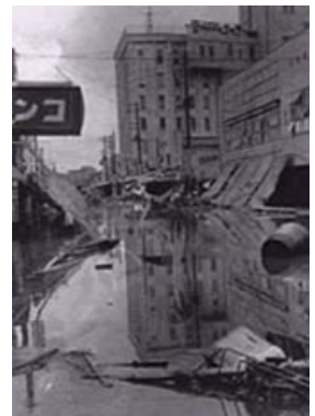
▲白川水害 下通り付近 (熊本県熊本市)
