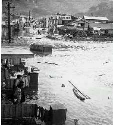
▲チリ地震津波の状況 (奄美市屋仁川通り)
